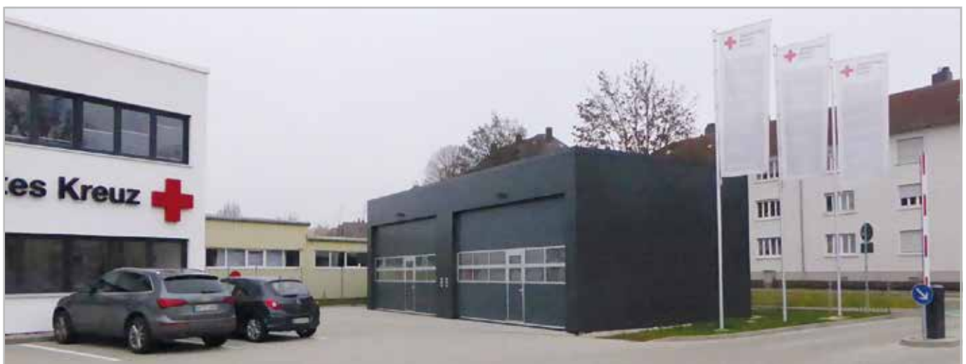
DRK-ZENTRUM OFFENBURG: Seit 1. April 2014 sind alle Einrichtungen des DRK in Offenburg konzentriert am neuen Standort in der Rammersweierstraße. Als letzter Baustein auf dem DRK-Gelände ist nun eine Fahrzeughalle fertiggestellt worden. Sie besteht aus zwei Doppelgaragen, die von der Rettungswache und vom DRK-Ortsverein genutzt werden. Ab Anfang 2017 wird die Fahrzeughalle das erste Adipositas-Fahrzeug des Kreises beherbergen. Das Spezialfahrzeug soll den Transport übergewichtiger Personen erleichtern.
